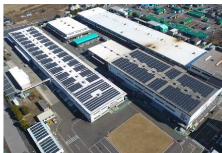
東北セキスイハイム工業株式会社に設置した太陽光発電設備
